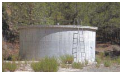
Citerne de 90 m 3 en béton (Chypre)
